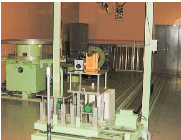
図3 増設棟竣工前の第3照射室でのサーベイメータ校正の様子（1999年当時） 校正台車のレールに近接して設置されている 2\pi 照射装置が左奥に見える。
