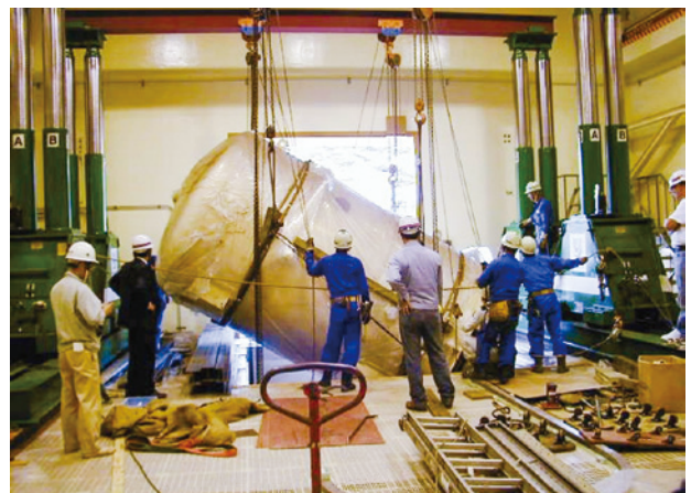
図4 4MVペレトロン加速器本体の搬入作業の様子（2000年）
